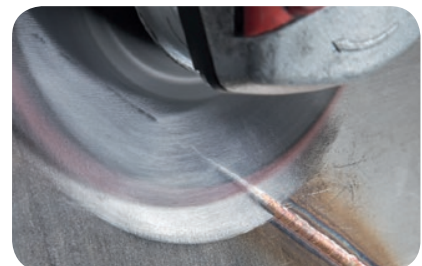
... desbastar y realizar el acabado en un paso de trabajo
