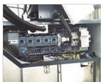
Sistema de control completo en DC
